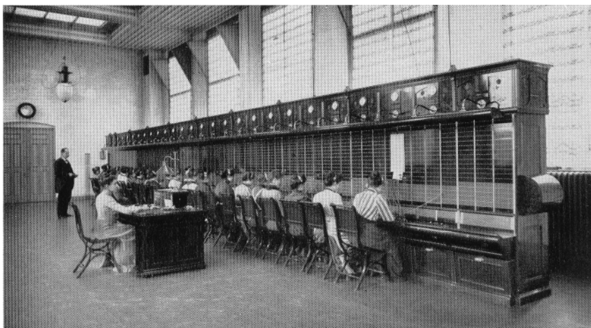
Fig. 15 L M Ericssons första CB-station, levererad till Haag år 1903
