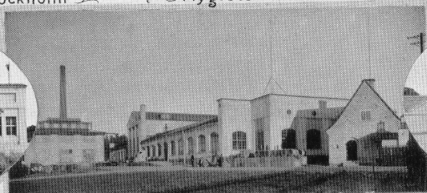
Kabelverket i Älvsjö invid Stockholm
