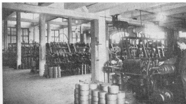
R 240 Fig. 4. Spinning av pappers- och bomullsisolerad tråd.
