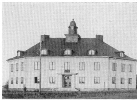
R 248 Fig. 11. Administrationsbyggnaden.
